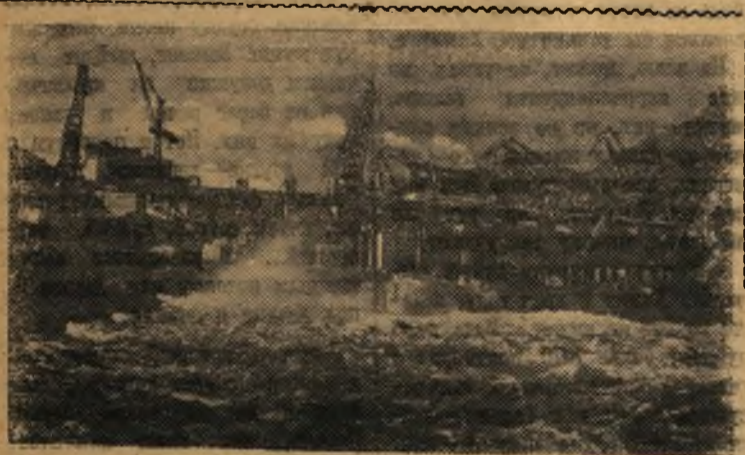
Восточно-Казахстанская область. В День строителя пущен первый агрегат Бухтарминской гидроэлектростанции.
