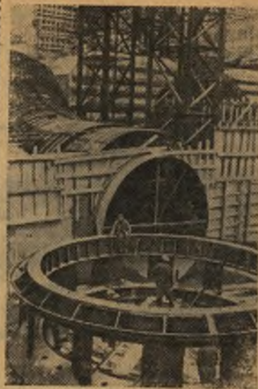
Иркутская область. Строители Братской ГЭС установили в проектное положение статор первого гидроагрегата.
